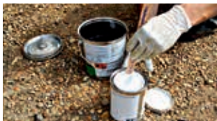
Rør i hærderen
