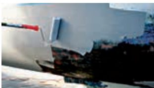
Påfør Hempel's Underwater Primer på overfladen
