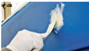
Udfyld ujævnheder med spartel
