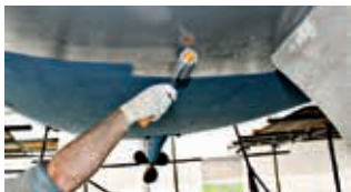
Påfør Hempel's High Protect med rulle
